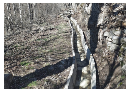
El canal en obres. Aj. Angostrina
