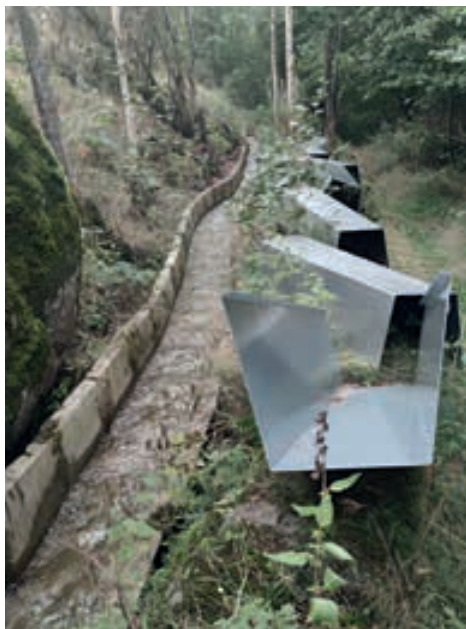
A l'esquerra, punt de captació del canal d'Angostrina. A la dreta, reformes actuals al canal.
