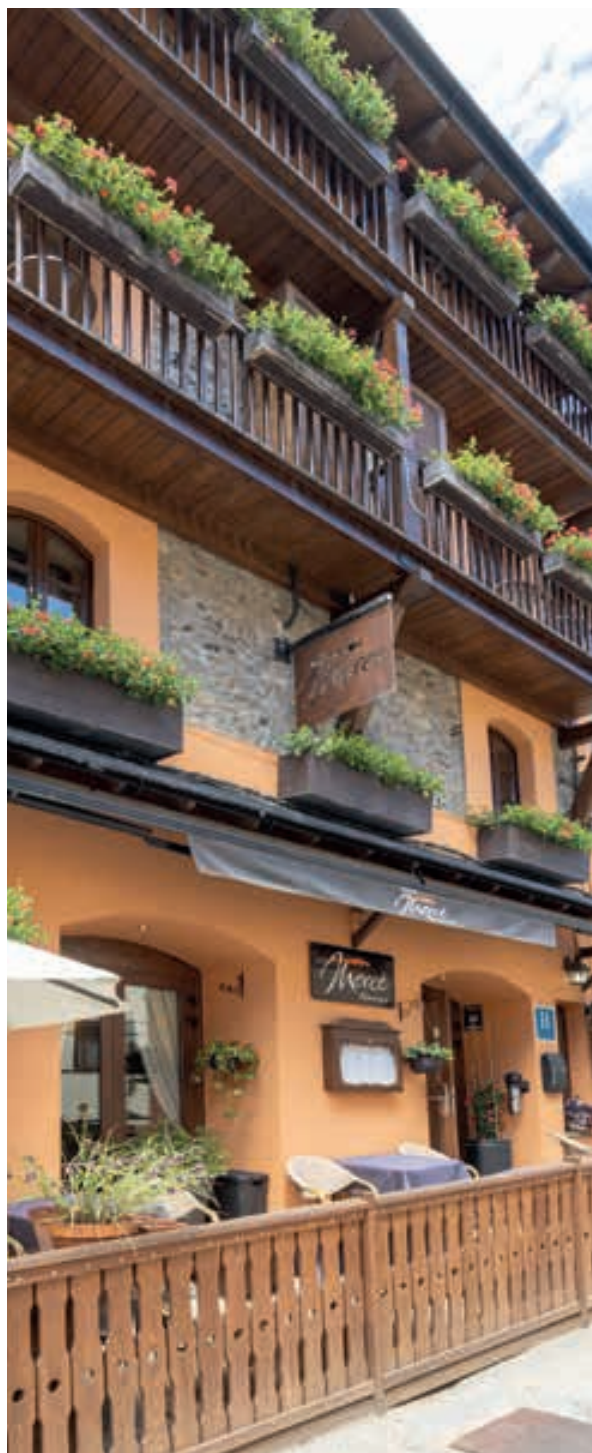
Façana i terrasseta de la fonda, actualment. Foto: Xavier Roura Sánchez.
