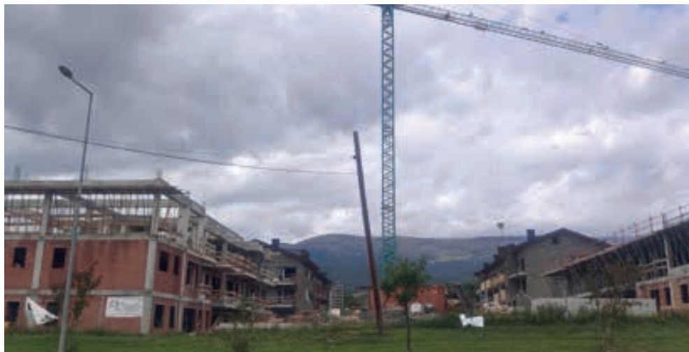
Els nous blocs de pisos en construcció a cal Barrier.
