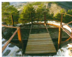
Adequació de la torre nord-oest
