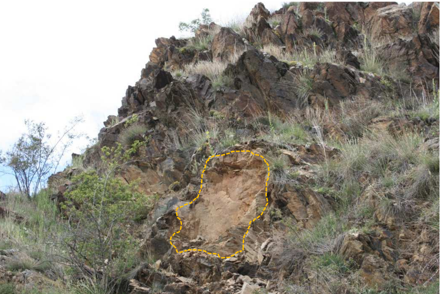
Fotografia 6: Detall de la cicatriu del despreniment del 26 de maig.
