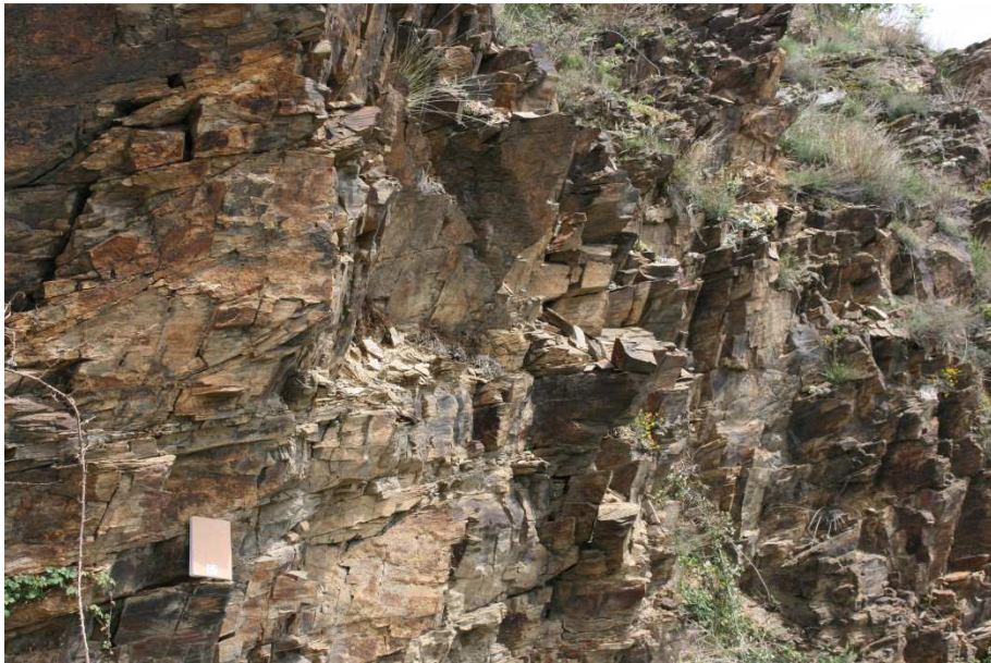
Fotografia 9: Escarpament d'uns 6 m d'alçada a la vertical del cobert del número 41. S'observa l'elevat grau de fracturació i el despreniment de blocs de mida decimètrica.
