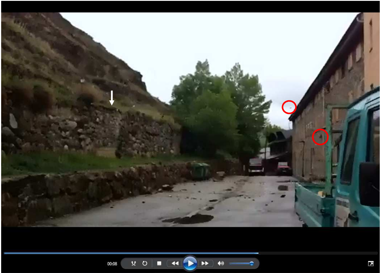
Fotografia 22: Instantània del vídeo enregistrat durant la purga executada pels bombers. A la dreta de la imatge s'observen dos fragments que han sortit projectats després que el bloc principal es fragmentés a l'impactar amb el terra de la part superior del carrer d'Estavar (fletxa blanca).
