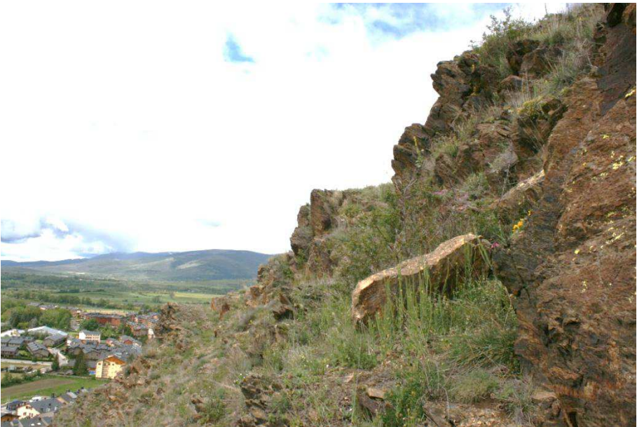
Fotografia 14: Aspecte del massís rocós i detall del despreniment d'un bloc de forma tabular que ha quedat aturat al vessant, molt a prop de la zona de sortida.
