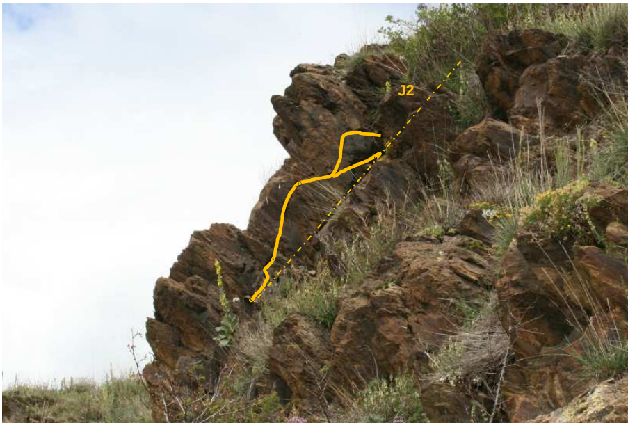
Fotografia 19: Vista d'una massa rocosa amb esquerdes de descompressió (línia contínua) de fins a 3 cm d'obertura i on s'observa clarament la família J2 (línia discontinua), paral·lela al vessant. Situada a la vertical del número 37.
