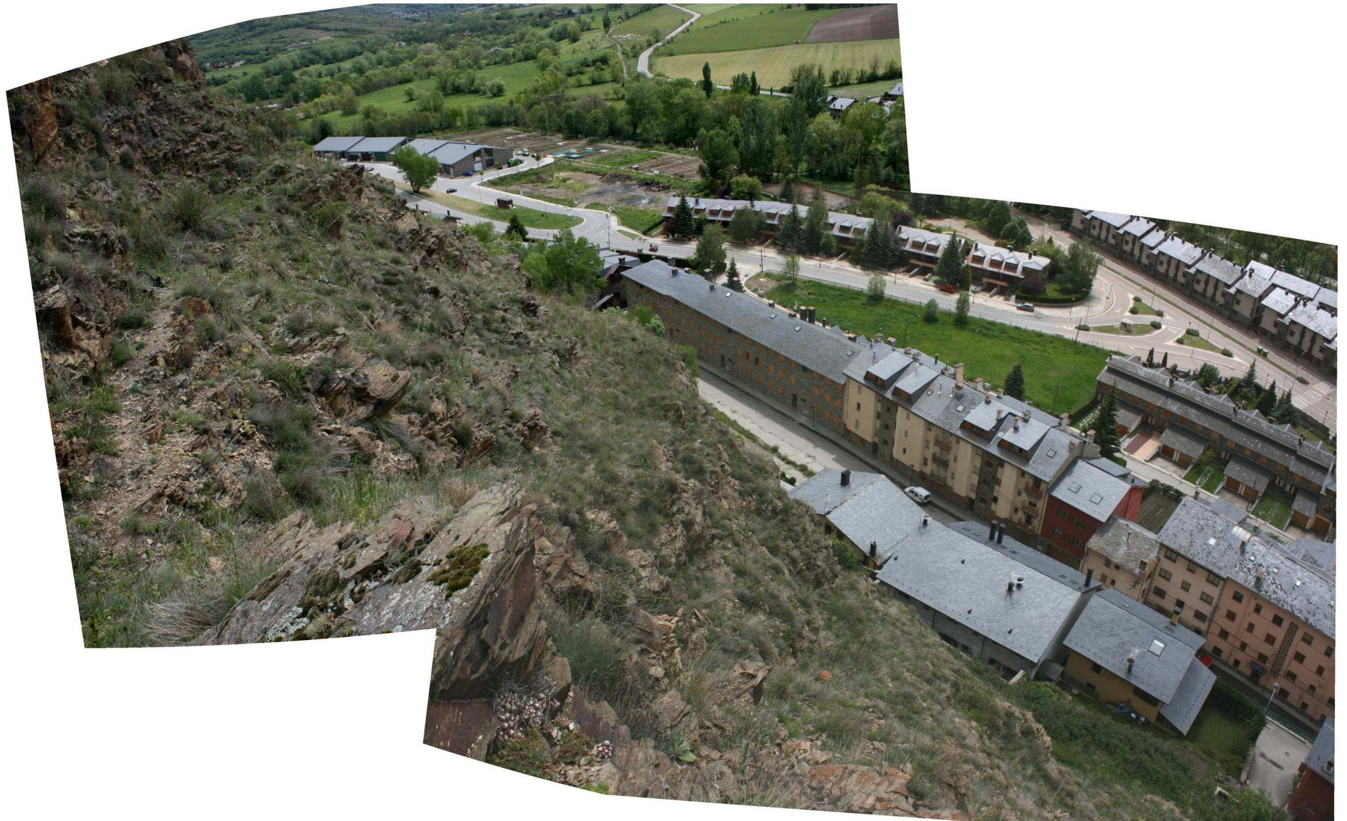
Fotografia III: Vista panoràmica de l'aspecte del vessant sud del turó del Castell, amb diversos escarpaments i un massís rocós molt fracturat.
